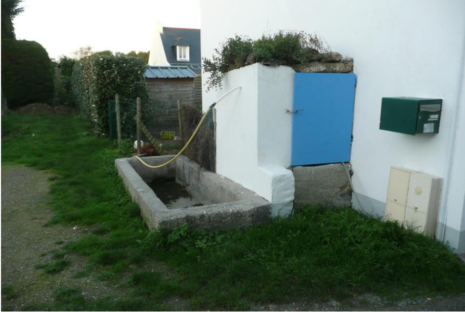
1 - Puits et son auge.
