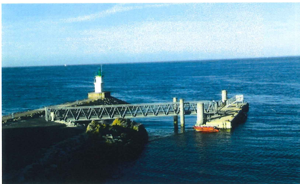
Ponton d'accostage de l'avant-port de Sauzon
